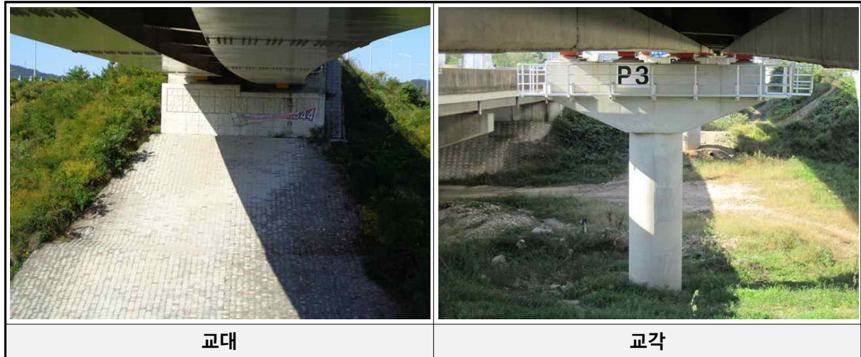
[교대 및 교각 전경]
