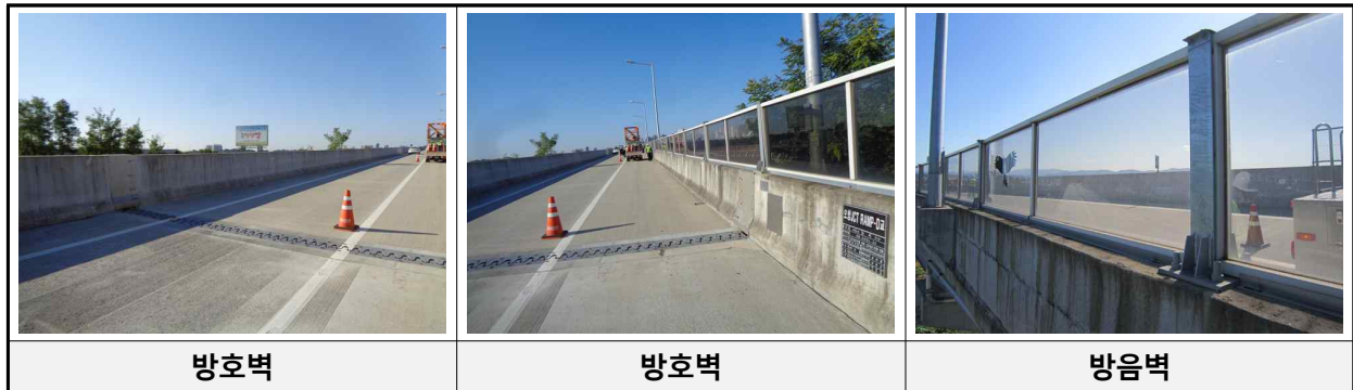
[방호벽 및 방음벽 전경]
