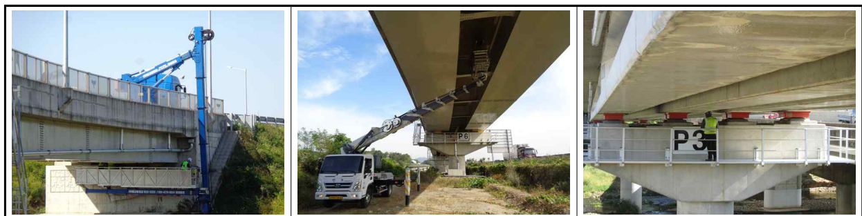
[고소작업차, 굴절점검차를 이용한 근접조사 실시]
